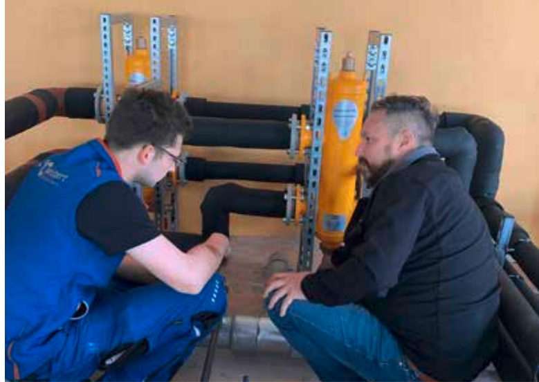
Die SpiroCross wurden versetzt zueinander installiert.
