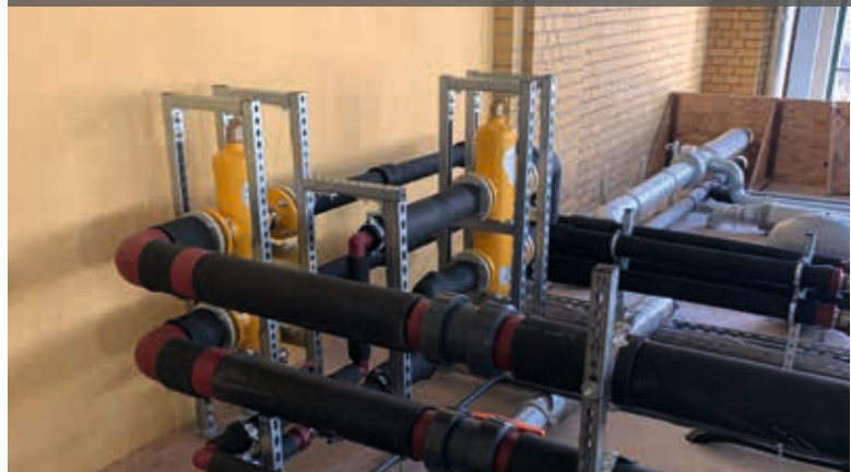
Die SpiroCross wurden versetzt zueinander installiert.
