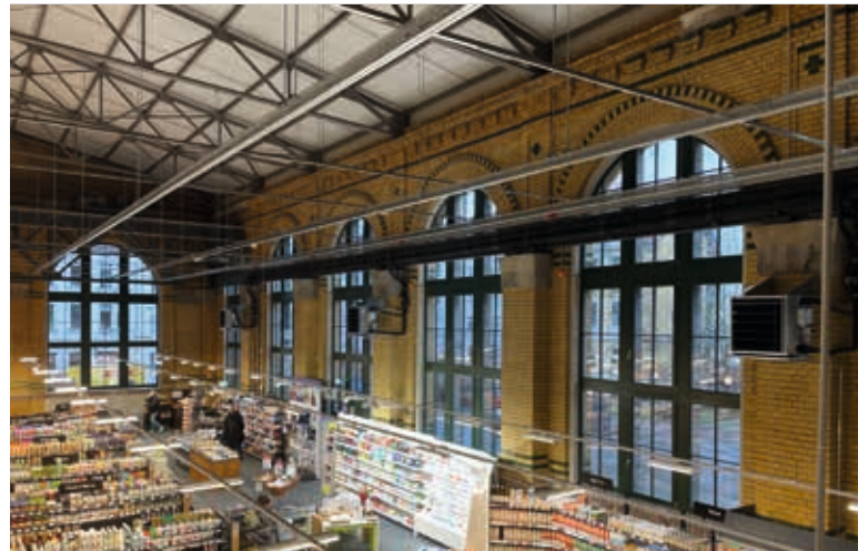
Die Klimageräte zum Kühlen und Heizen befinden sich im oberen Wandbereich zwischen den Fenstern.
